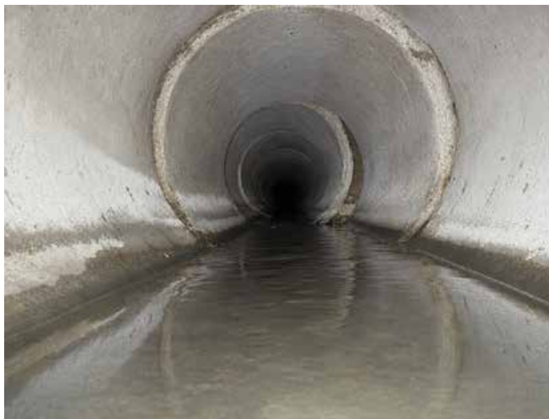
Exemple d'images obtenues lors d'une inspection télévisée
