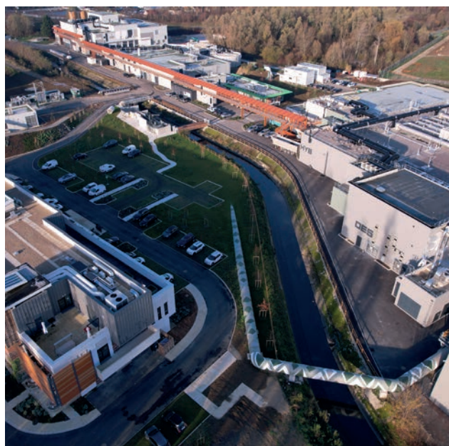
Vue partielle de la station du SIAH
