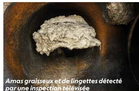
Amas graisseux et de lingettes détecté par une inspection télévisée
