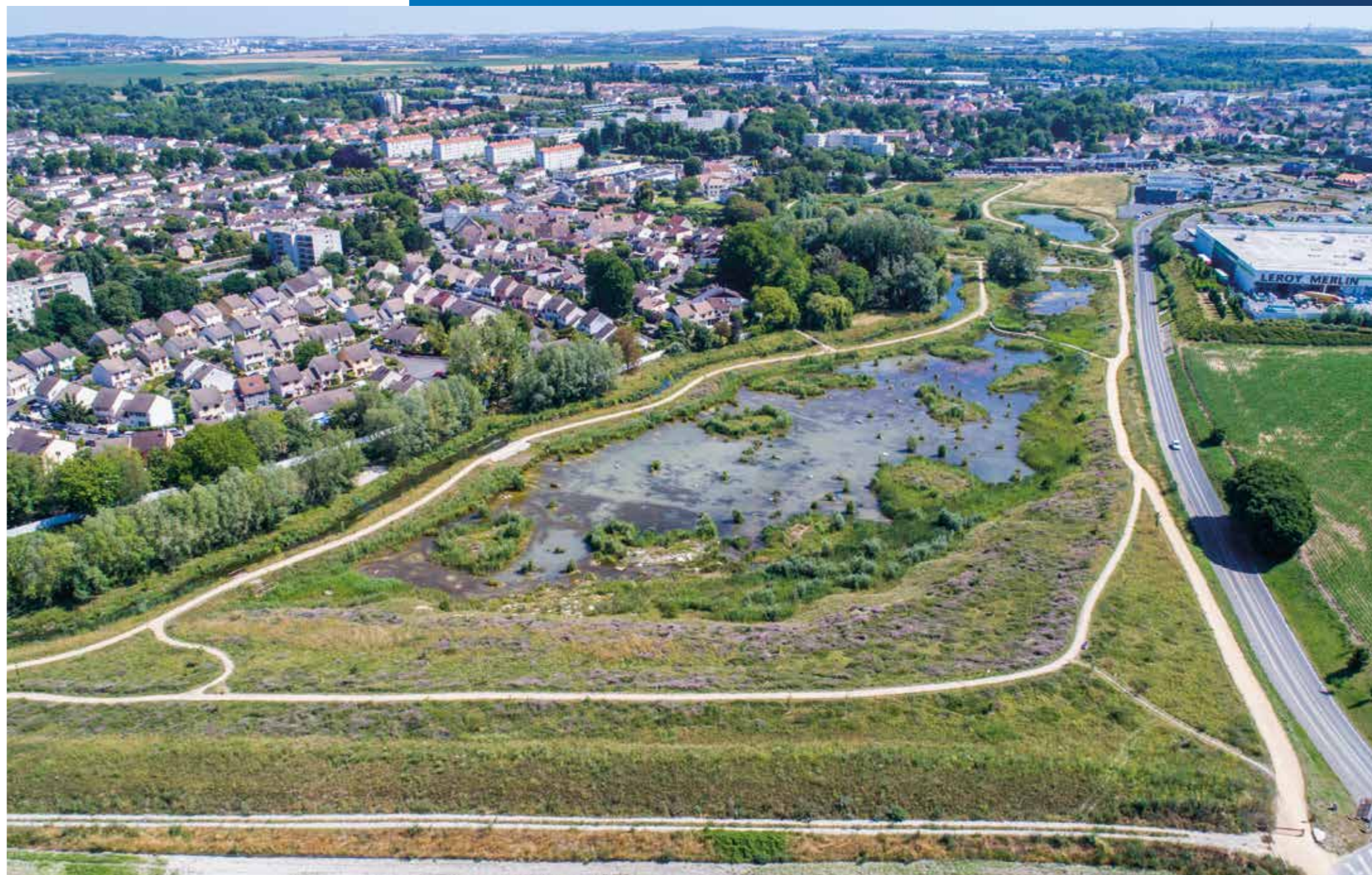
Zone d'expansion de crue du Vignois
