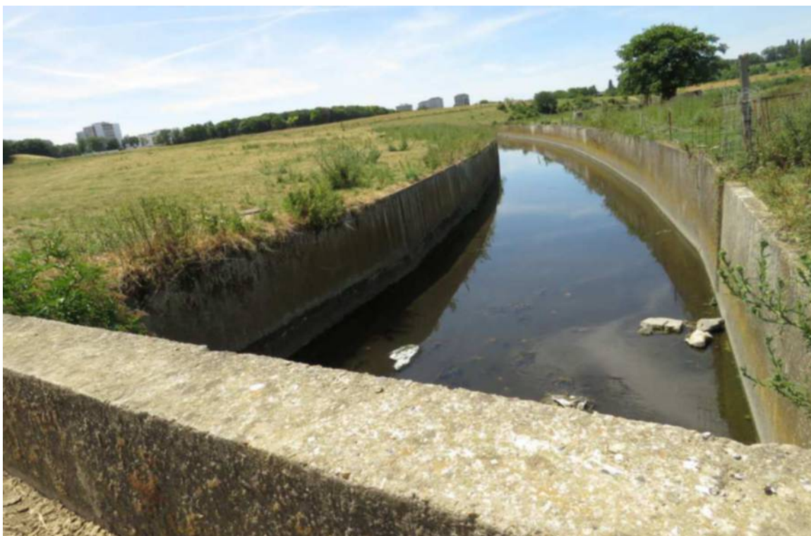
Arnouville, hier. Cet ouvrage bétonné de 500 m avait été construit pour détourner le cours du Petit-Rosne. Mais le Siah n'avait pas suivi les procédures d'expropriation. Le syndicat va donc le démolir et le reconstruire un peu plus loin. Coût : 1 M€. (LP/AL)
