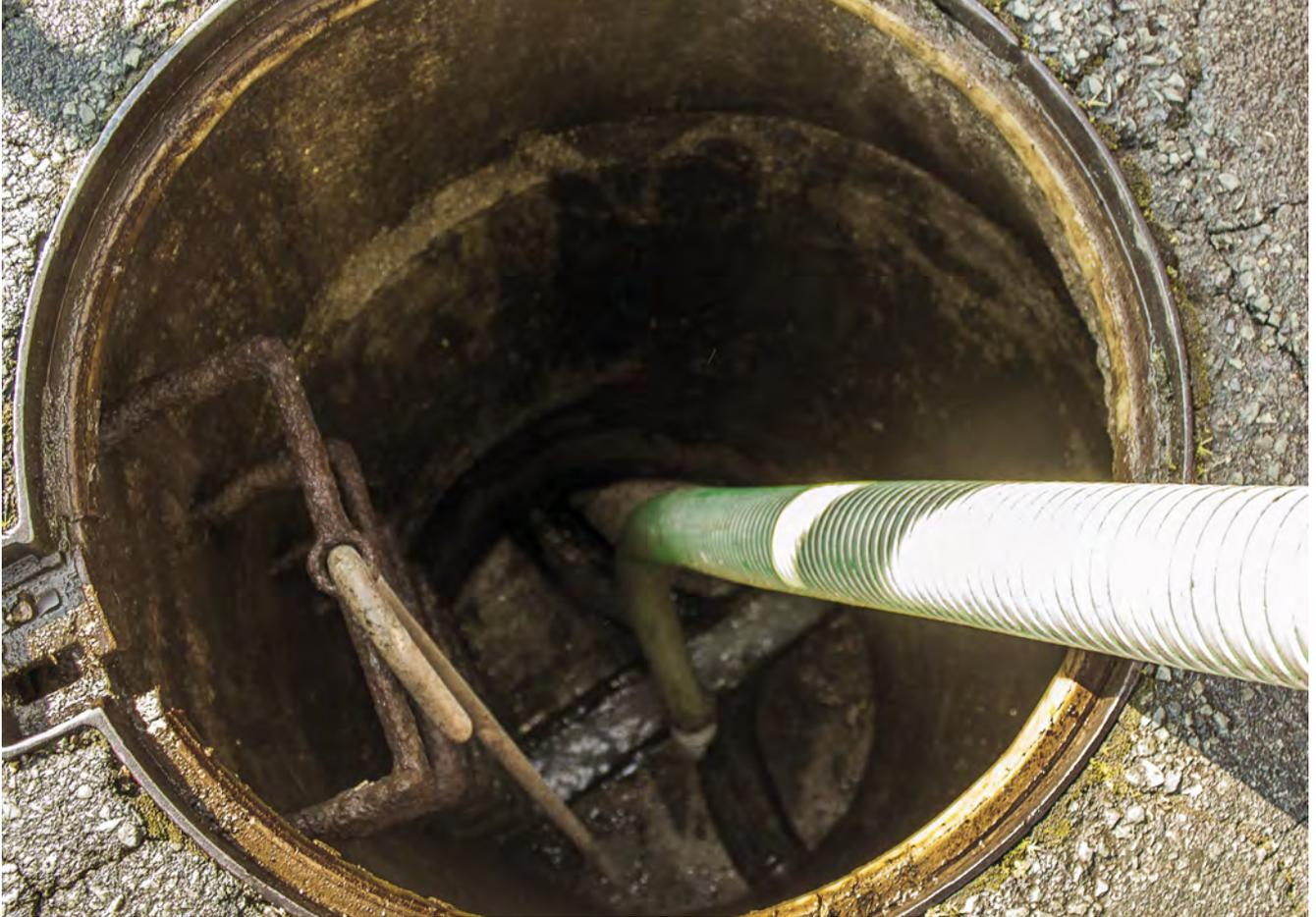
canalisations communales d'eaux usées ont été curés ainsi que 1 180 mètres de canalisations communales d'eaux pluviales. 1007 tonnes de sable ont été extraites de ces ouvrages en 2016.
