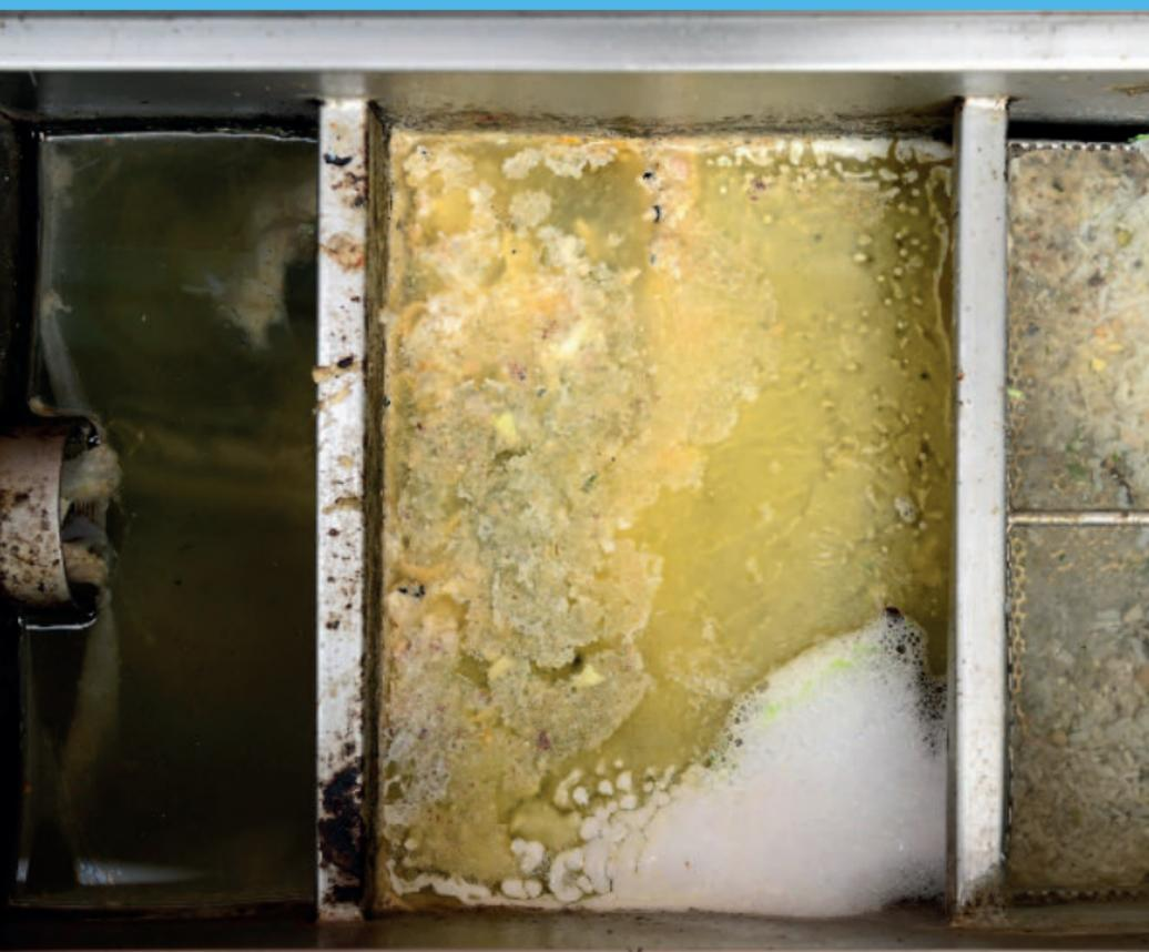
La graisse est un fléau majeur pour les canalisations. En effet, elle engendre bien souvent des bouchons, empêchant ainsi les eaux usées de s'écouler correctement, provoquant la mise en charge des réseaux. Afin d'endiguer ce problème, une solution simple existe : l'installation de bacs à graisses.
