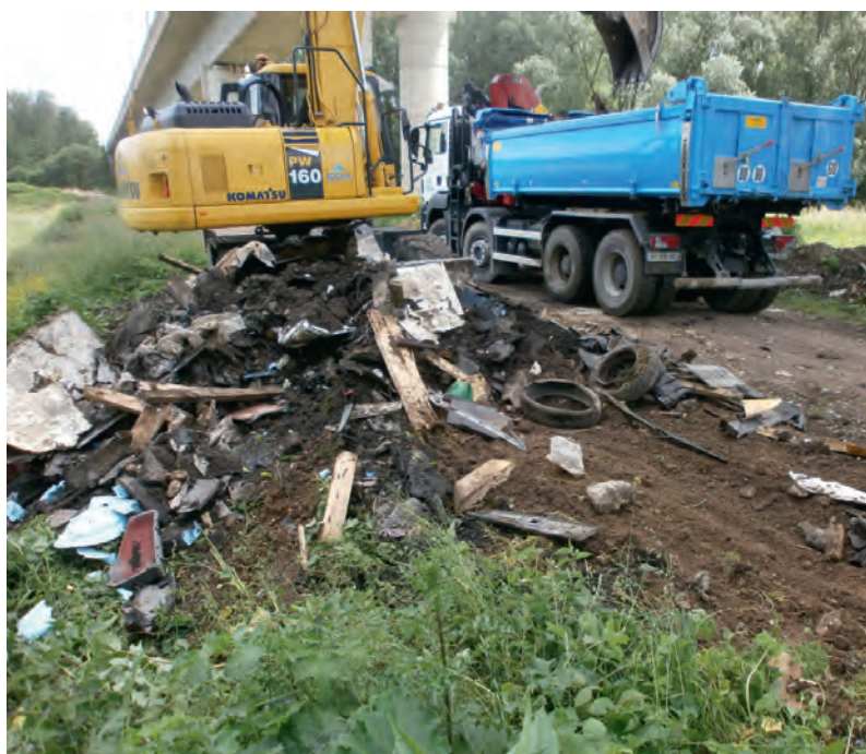
↓ Nettoyage des abords d'un bassin de retenue
