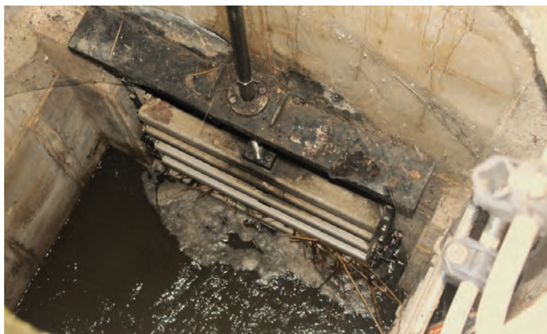
↑ Vue plongeante sur une vanne hydraulique
