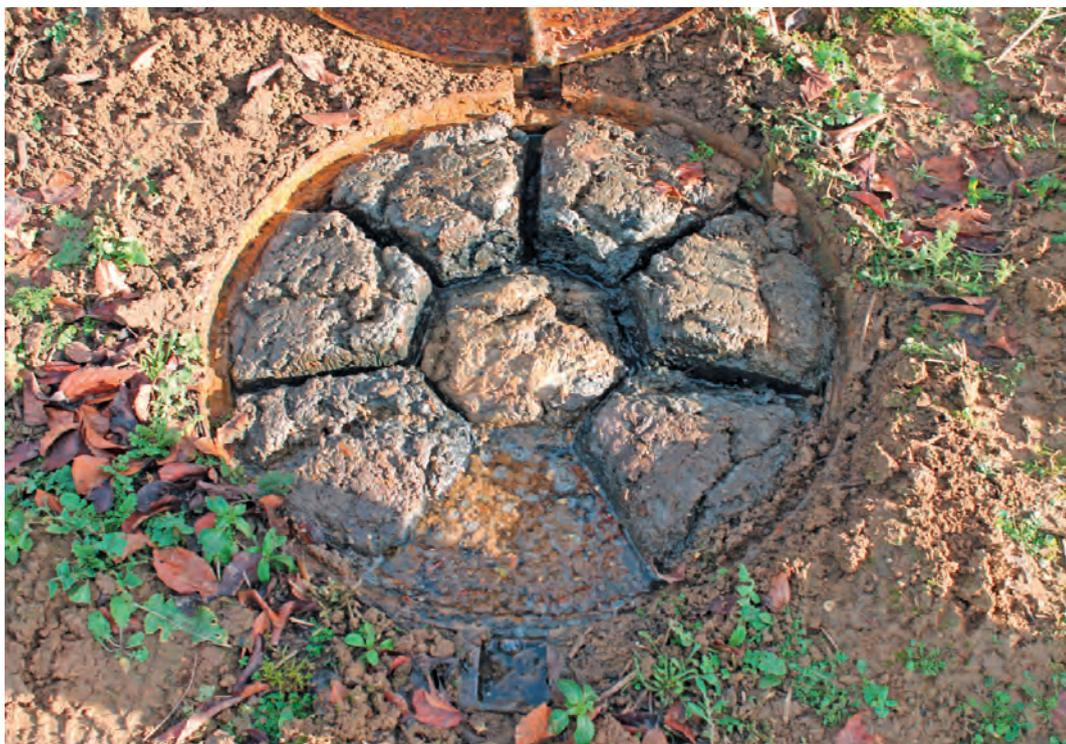
← Cette marguerite de graisse provient d'un bouchon qui s'est formé à l'intérieur de la canalisation empêchant l'écoulement des eaux usées. Le réseau s'est alors mis en charge et à la surface de l'eau un amas de graisse s'est constitué.
