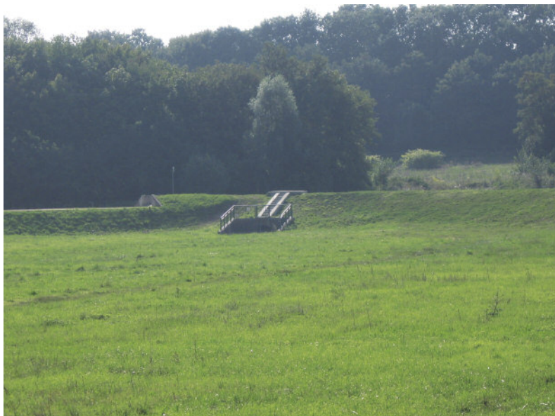
↑ Vue sur la digue
