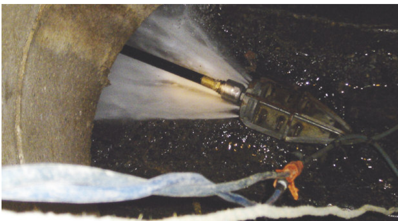
Tête de curage propulsée par des jets d'eau à haute pression ↓
