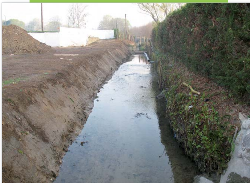
← Ce cliché est pris à l'autre bout du tronçon de rivière. La berge a été nettoyée et fauchée. Sur la droite, on distingue des pousses de renouée du Japon qui émergent déjà du sol. La berge de gauche a été nettoyée et taillée en biseau pour les aménagements ultérieurs
