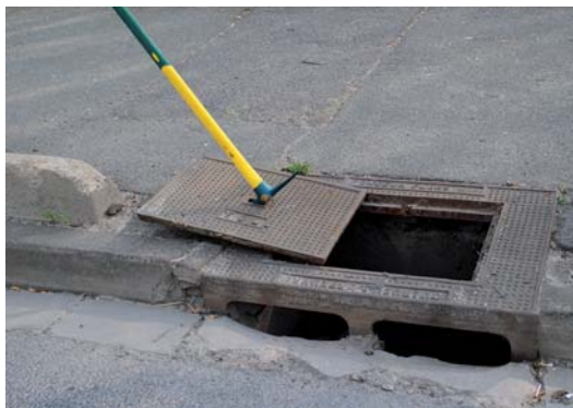
↑ Inspection d'un avaloir : le réseau doit assurer la bonne évacuation des eaux pluviales.
