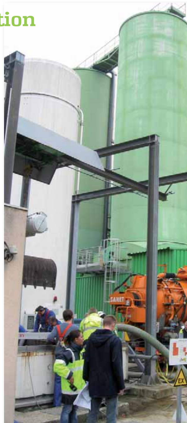
↑ Ici le curage de la "fosse à bâtards", premier ouvrage de traitement des eaux usées.
