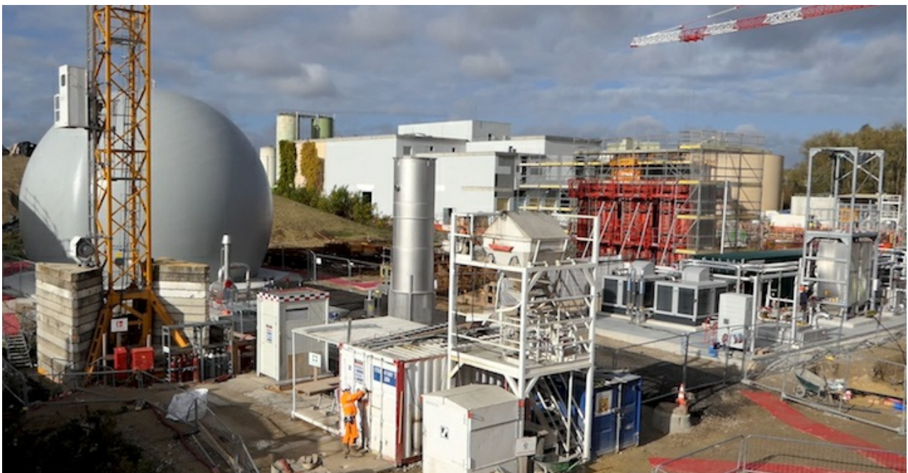
Travaux de la nouvelle installation de méthanisation de la STEP de Bonneuil, avec en fond l'actuel digesteur, photo SIAH
