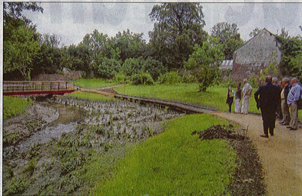
■ Visite des travaux en présence du maire de Sarcelles, la semaine dernière. À ses côtés, Éric Chanal, le directeur général du SIAH, Didier Guevel, maire du Plessis-Gassot, en charge des travaux pour le SIAH, ainsi que Nathalie Cadiou, paysagiste en charge du projet écologiste.
