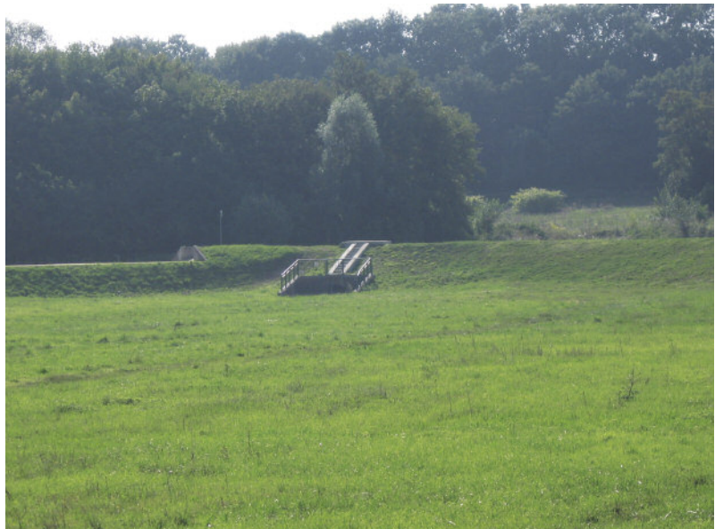
↑ Vue sur la digue
