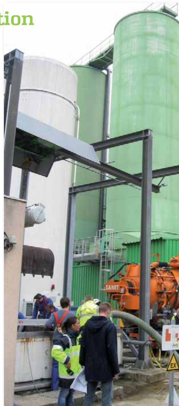
↑ Ici le curage de la "fosse à bâtards", premier ouvrage de traitement des eaux usées.
